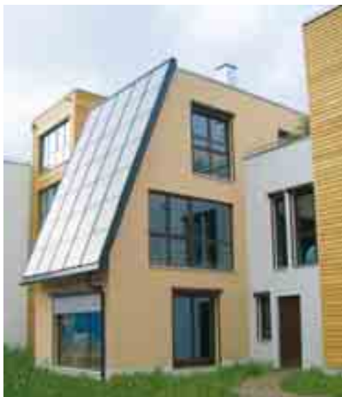
2009: Erster Preis an Timo Leukefeld für die Integration der solarthermischen Anlage in das Gesamtensemble dieses von der FASA AG in Chemnitz geplanten und gebauten Hauses.
