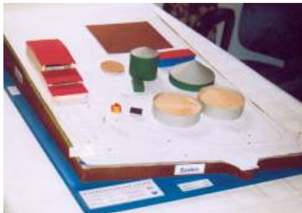
Das Modell der Bioanlage, deren Herzstück der Fermenter ist, das hohe grüne Gebäude in der Mitte. Die roten Dächer links beherbergen Blockheizkraftwerk und Holzhackschnitzelheizwerk.
